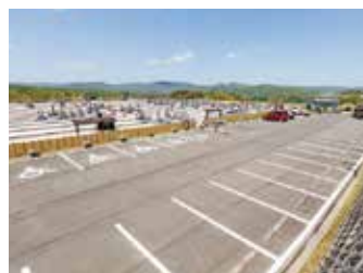
36台分を確保した 広い駐車場
